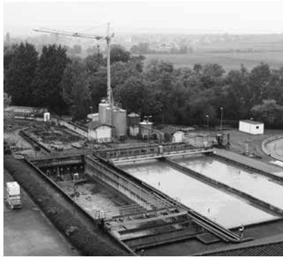
Das Klärwerk von Monsheim von oben
