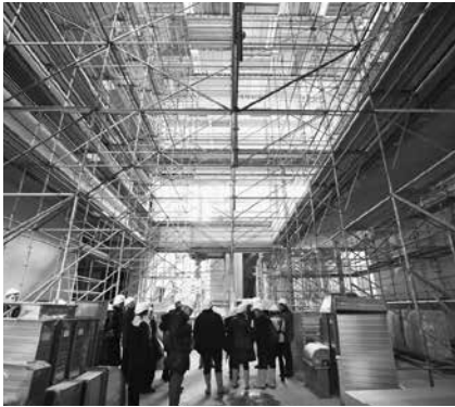
Im Neubau der Kunsthalle Mannheim
