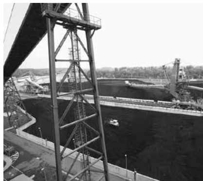
Der Kohlevorrat vor dem EnBW-Kraftwerk
