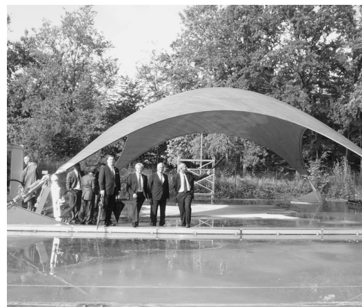
Die Delegation besichtigt die u.a. vom Illek entwickelte »Smart Shell«. Die Holzschale kann sich an vier Punkten individuell bewegen und passt sich mithilfe von Sensoren Belastungen etwa durch Wind und Schnee an.
