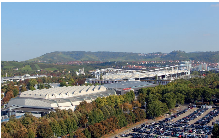
Die Hanns-Martin-Schleyer-Halle, deren Tragwerk von Prof. Jörg Peter geplant wurde. Bild: BasieB/iStock
